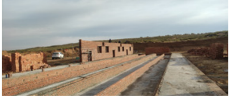
▲ 铺设蒙发田园综合体牛场排水沟护坡植草砖。
