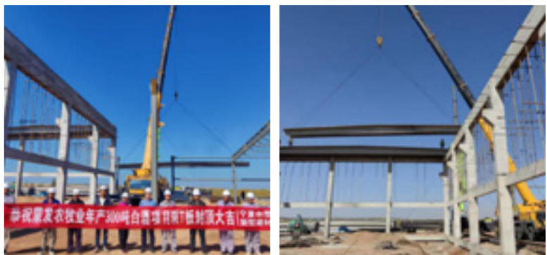
▲ 10月1日，蒙发田园综合体项目300吨白酒项目固态酿造车间24米跨双梯板吊装。
