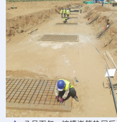
▲ 7月下旬，挖槽浇筑垫层后进行基础底板钢筋作业。
