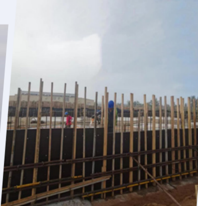
▲ 8月11日，储罐区围堰身模板槽内冲洗。
