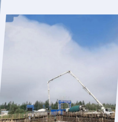
▲ 8月11日，储罐区基础圆柱、围堰墙身（1层）砼浇筑。
