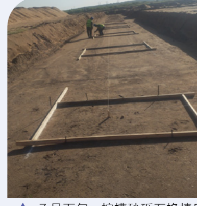
▲ 7月下旬，挖槽砂砾石换填后进行垫层支模。
